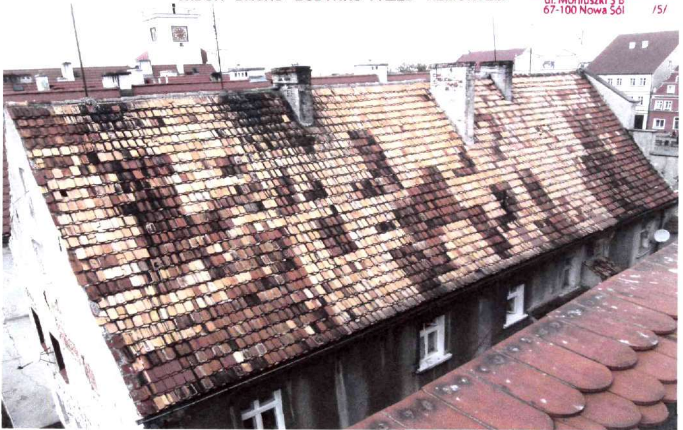
RYNEK 21 - WIDOK POŁACI DACHU - OD STRONY WSCHODNIEJ
