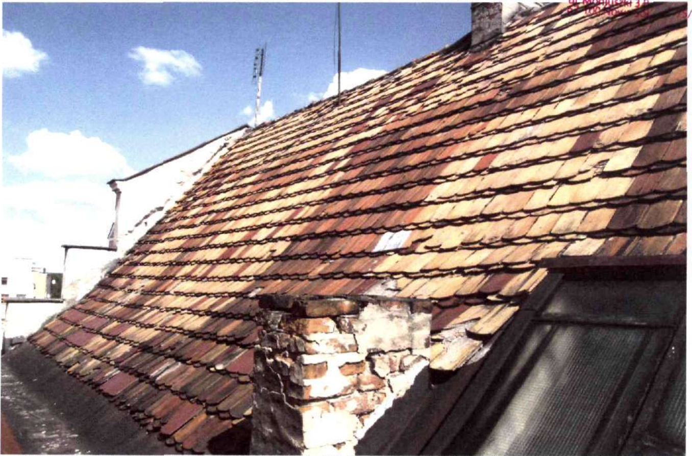
RYNEK 21 - WIDOK FRAGMENTU POŁACI DACHU – OD STRONY BUDYNKU RYNEK 22 /STRONA ZACHODNIA/
