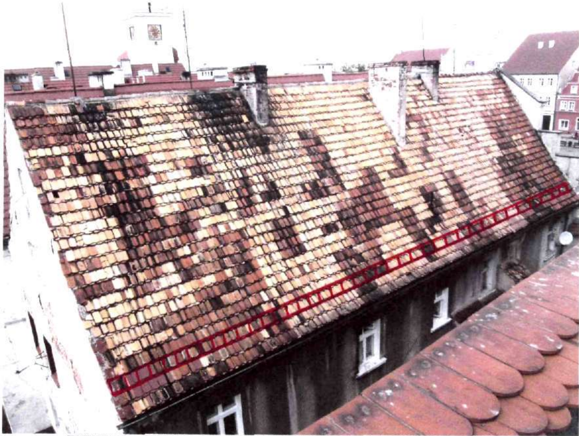
RYNEK 21 - WIDOK DACHU BUDYNKU OD STRONY WSCHODNIEJ
