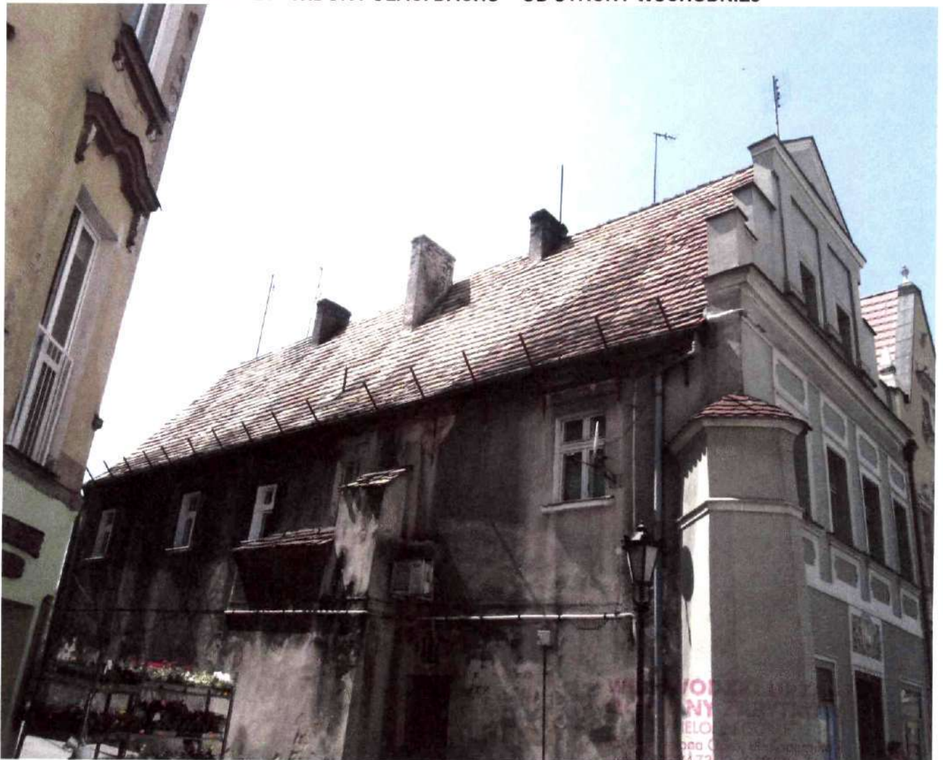
RYNEK 21 - WIDOK POŁACI DACHU - OD STRONY WSCHODNIEJ
