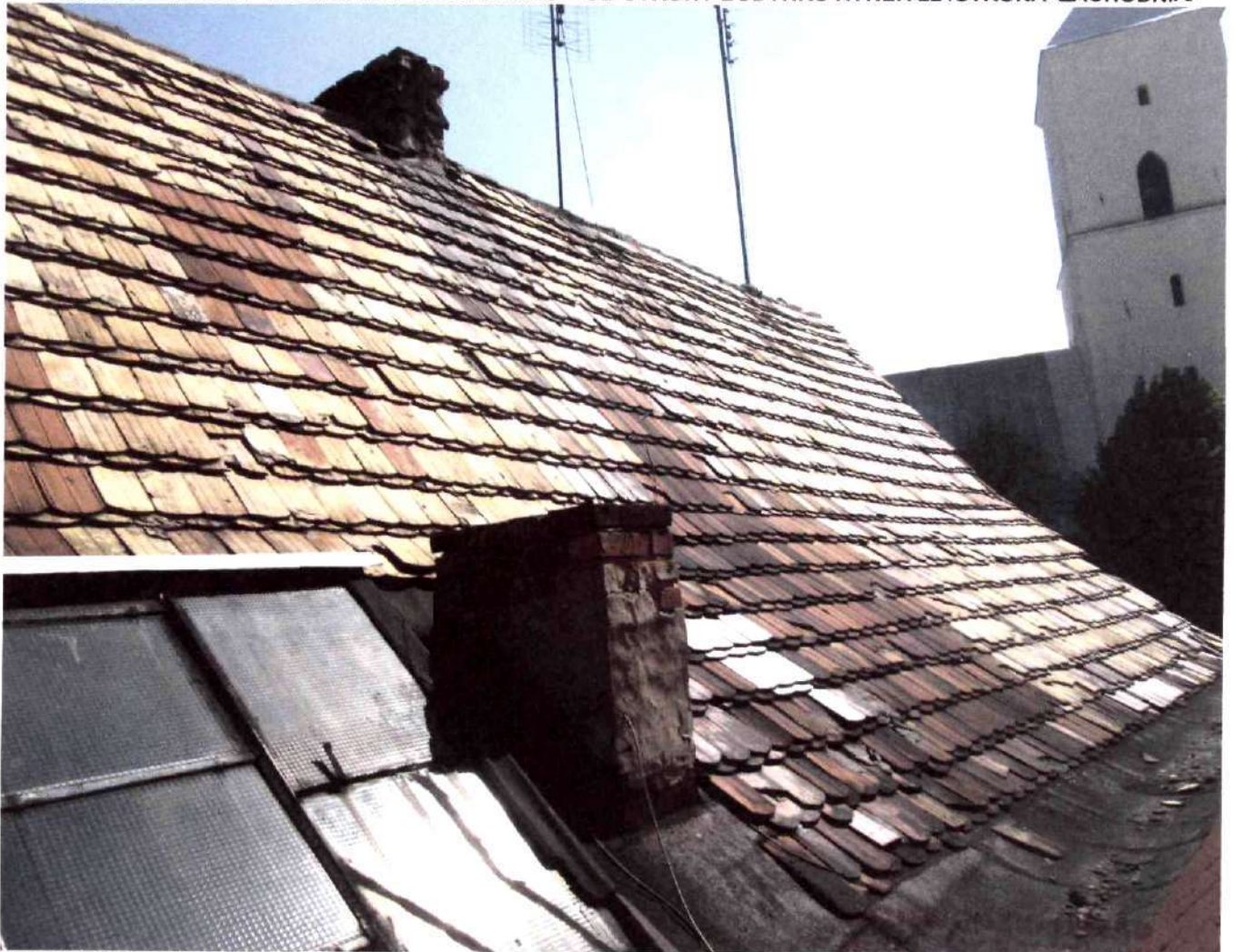
RYNEK 21 - WIDOK FRAGMENTU POŁACI DACHU – OD STRONY BUDYNKU RYNEK 22 /STRONA ZACHODNIA/
